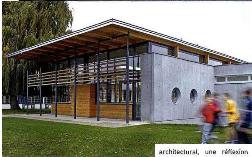
Restaurant scolaire du collège Gustave Doré à Hochfelden (67), de l'architecte Régis Mury (2003). source : Fibois - Fédération interprofessionnelle forêt bois Alsace
